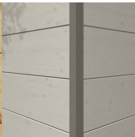
Nollanurkka ulkopuolelta, tasanousu
